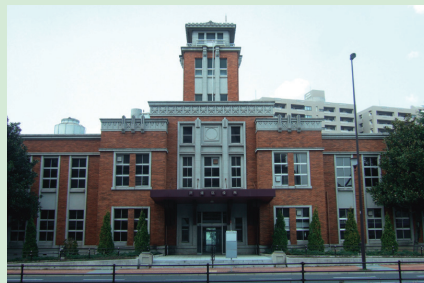
旧戸畑区役所 昭和8年に戸畑市役所として建てられ、北九州市役所発足当時は市役所の本庁舎としても使われていました。
