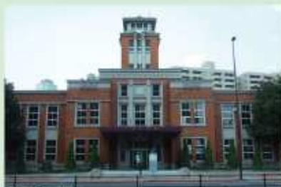
旧戸畑区役所 昭和8年に戸畑区役所として建てられ、北九州市役所発足当時は市役所の本庁舎としても使われていました。
