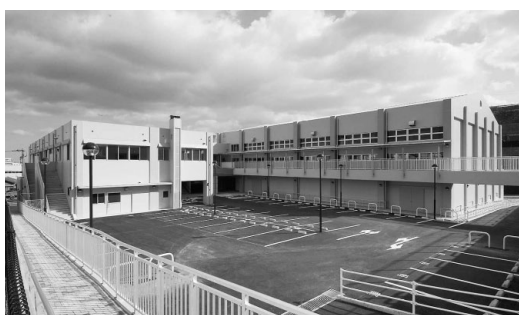
新門司地区複合公共施設 (右側が新門司体育館)
